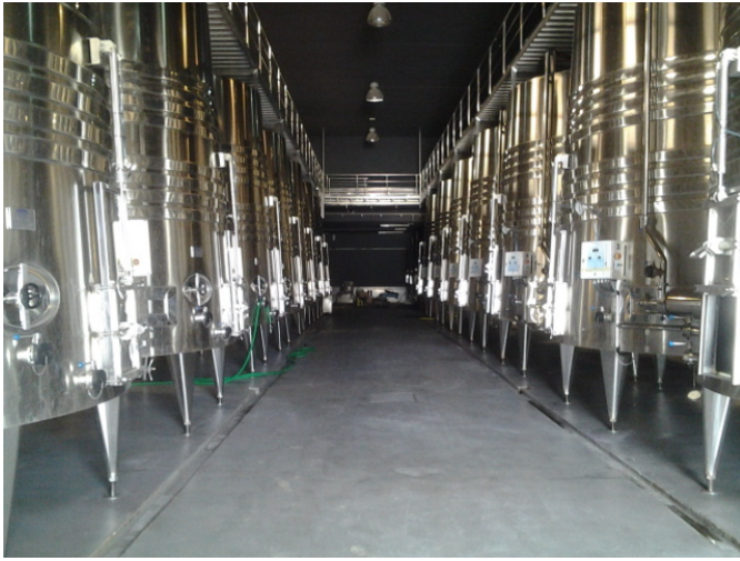
Sala de tinas de acero
