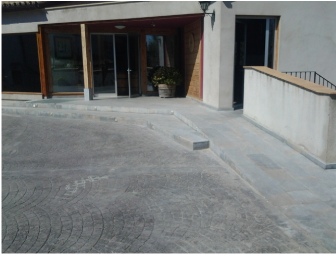
Acceso edificio principal
