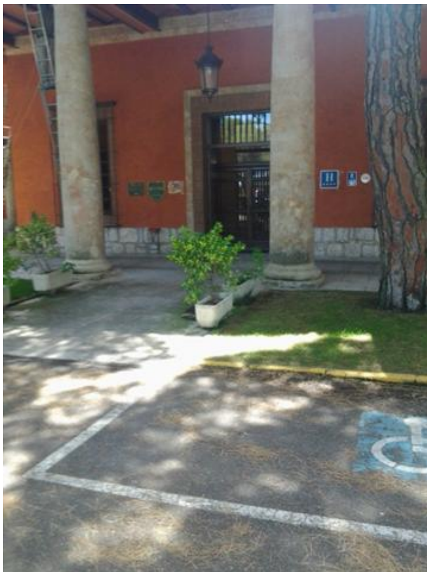
Entrada al establecimiento y plaza de aparcamiento para PMR
