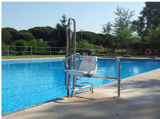
Grúa hidráulica para acceder al vaso de la piscina
