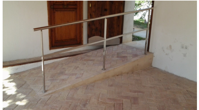
Rampa de acceso "Patio Zanón"
