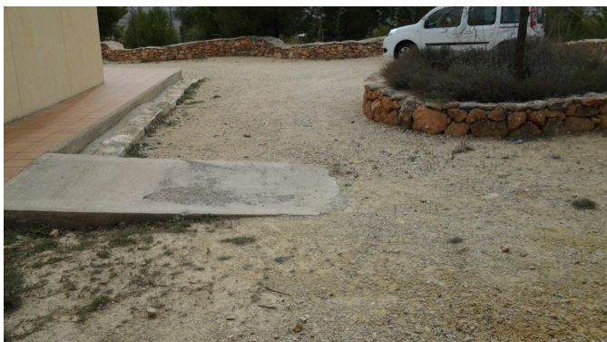
Rampa de acceso al establecimiento
