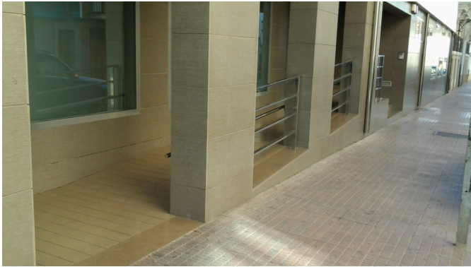
Rampa de acceso
