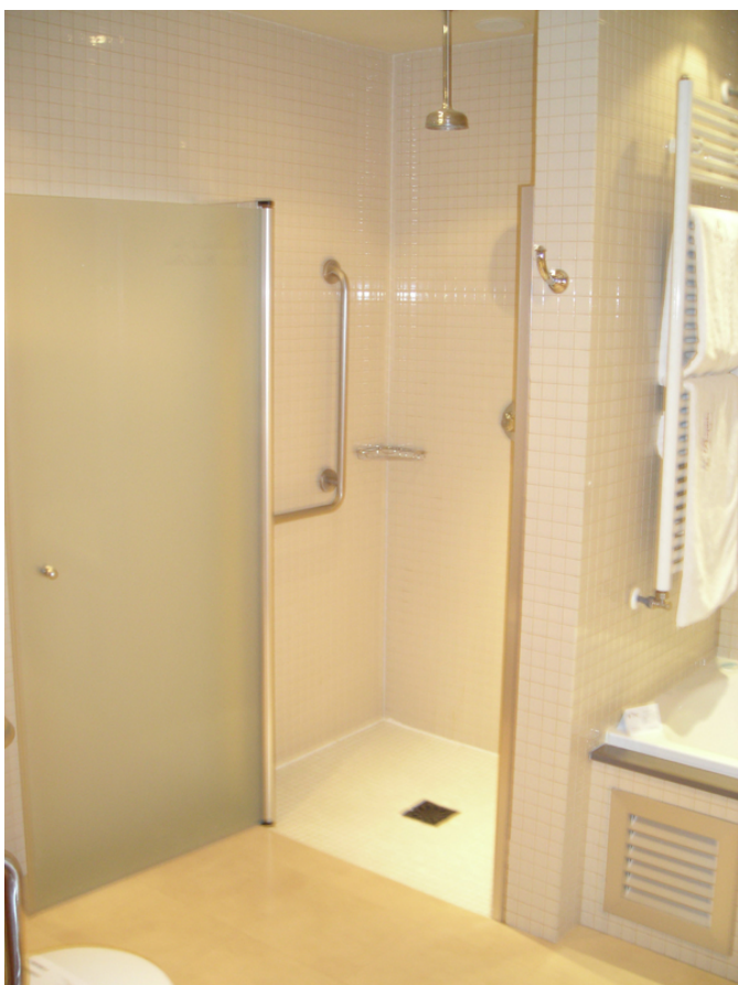
Ducha del cuarto de baño de la habitación adaptada
