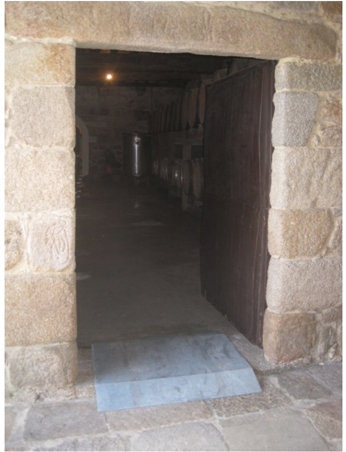
Acceso a Sala de Barricas y Sala de Catas
