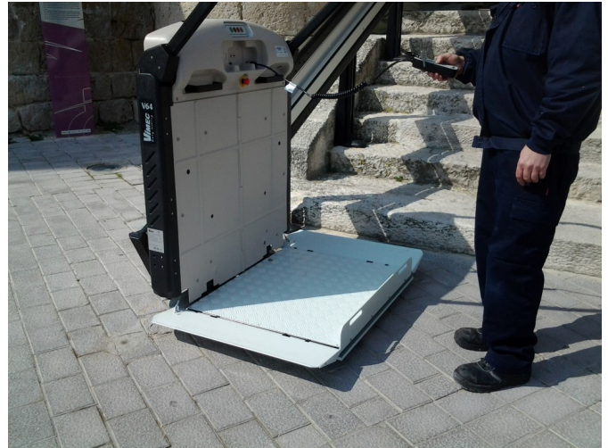
Acceso al establecimiento - Plataforma elevadora
