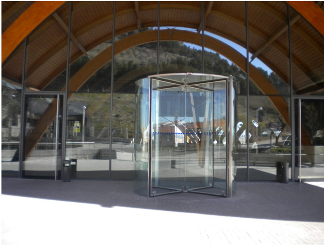
Entrada "Bodega nueva"
