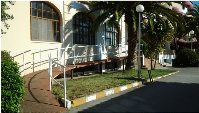
Rampa de acceso
