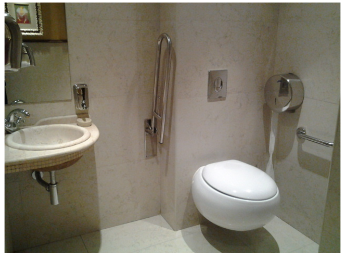
Aseo común adaptado
