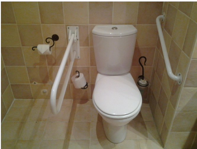
Aseo habitación adaptada
